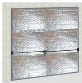
3 Finition en jointant les lés entre eux avec l'adhésif ALUDESIF®
